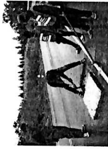
วัดความหนาผิวทางเดิมแล้วเก็บวัสดุผิวทางเดิมใส่ถุงเก็บวัสดุ
